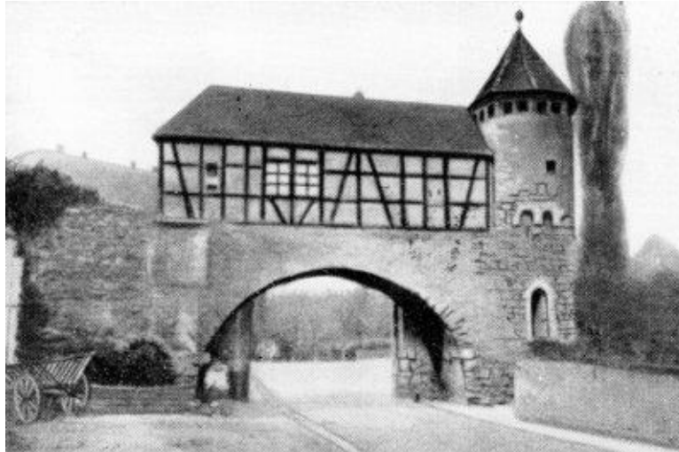
Bild 16: Das Rinntor mit den beiden unter dem Torbogen später angebrachten Stützmauern (kurz vor dem Abbruch).
