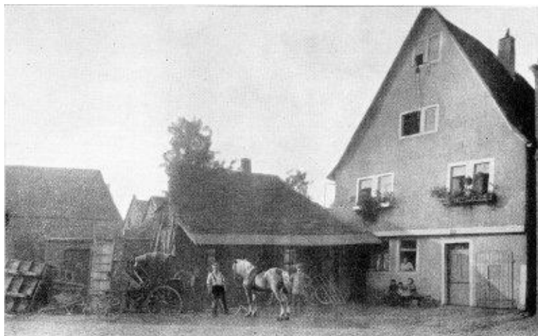
Bild 51: Meister Kleins Schmiede kurz vor ihrem Abbruch im September 1925.
