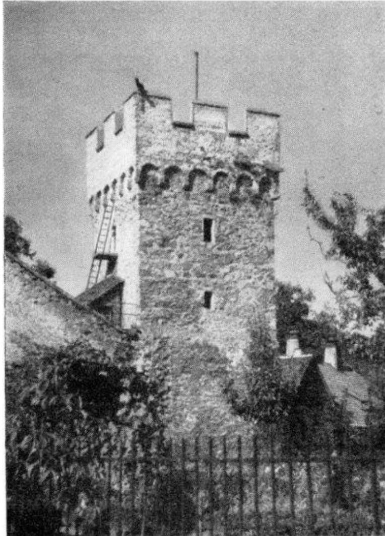
Bild 43: Bürgerturm, von Süden gesehen.
