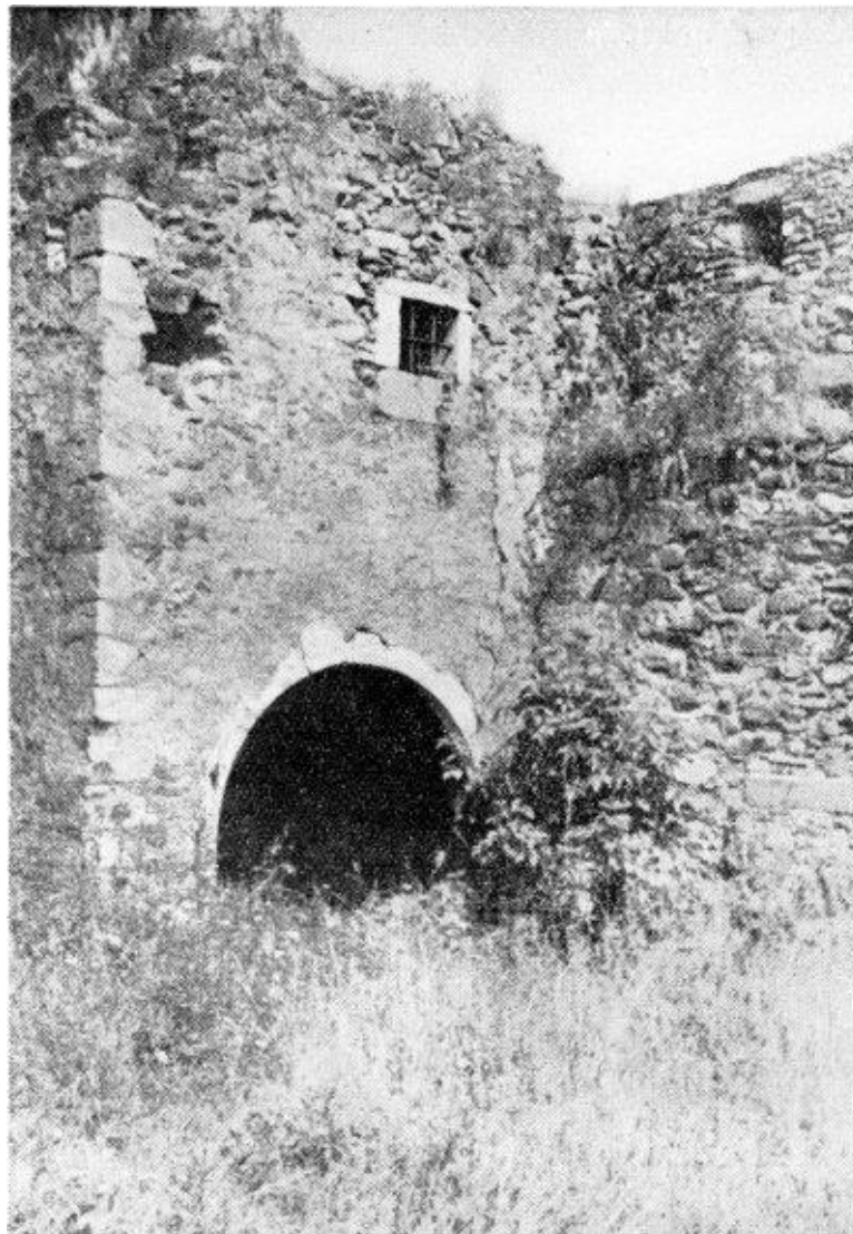
Bild 25: Eingang zum unteren Keller. Rechts alte Stadtmauer mit Wehrgang. (Bekanntlich bildete der Steinerhof einen Teil der Stadtbefestigung).
