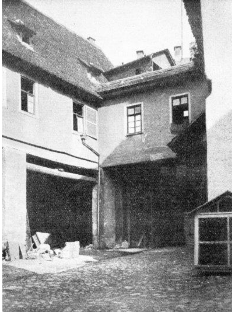
Bild 29: Offene Halle und Verbindungsgang zwischen Nord- und Südflügel (vom Hofe aus gesehen). Siehe Seite 73 und 77.
