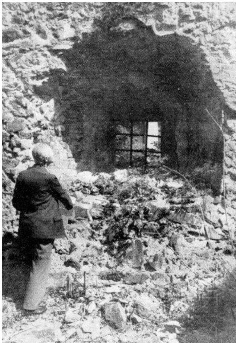
Bild 27: Fensternische im oberen Keller.
