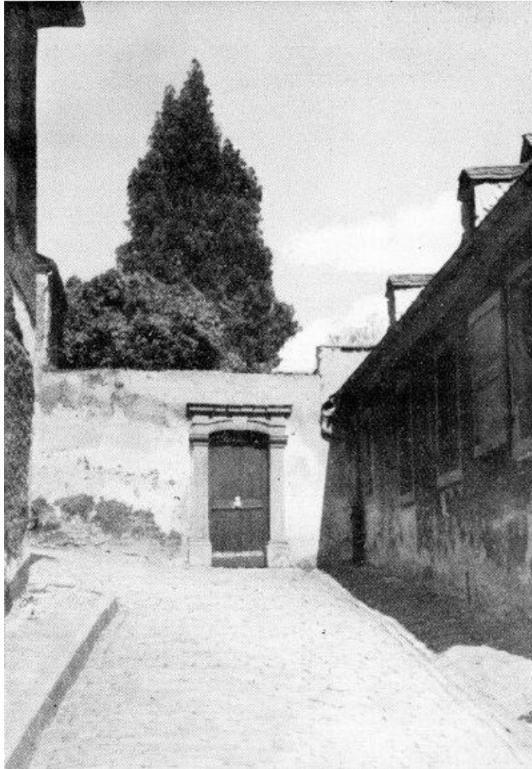
Bild 23: Blick zum Einnehmereigebäude mit Eingangsportal am Aufgang zum Kirchplatz
