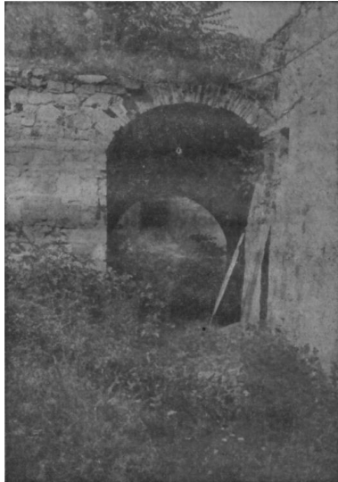
Eingang zum oberen Keller
